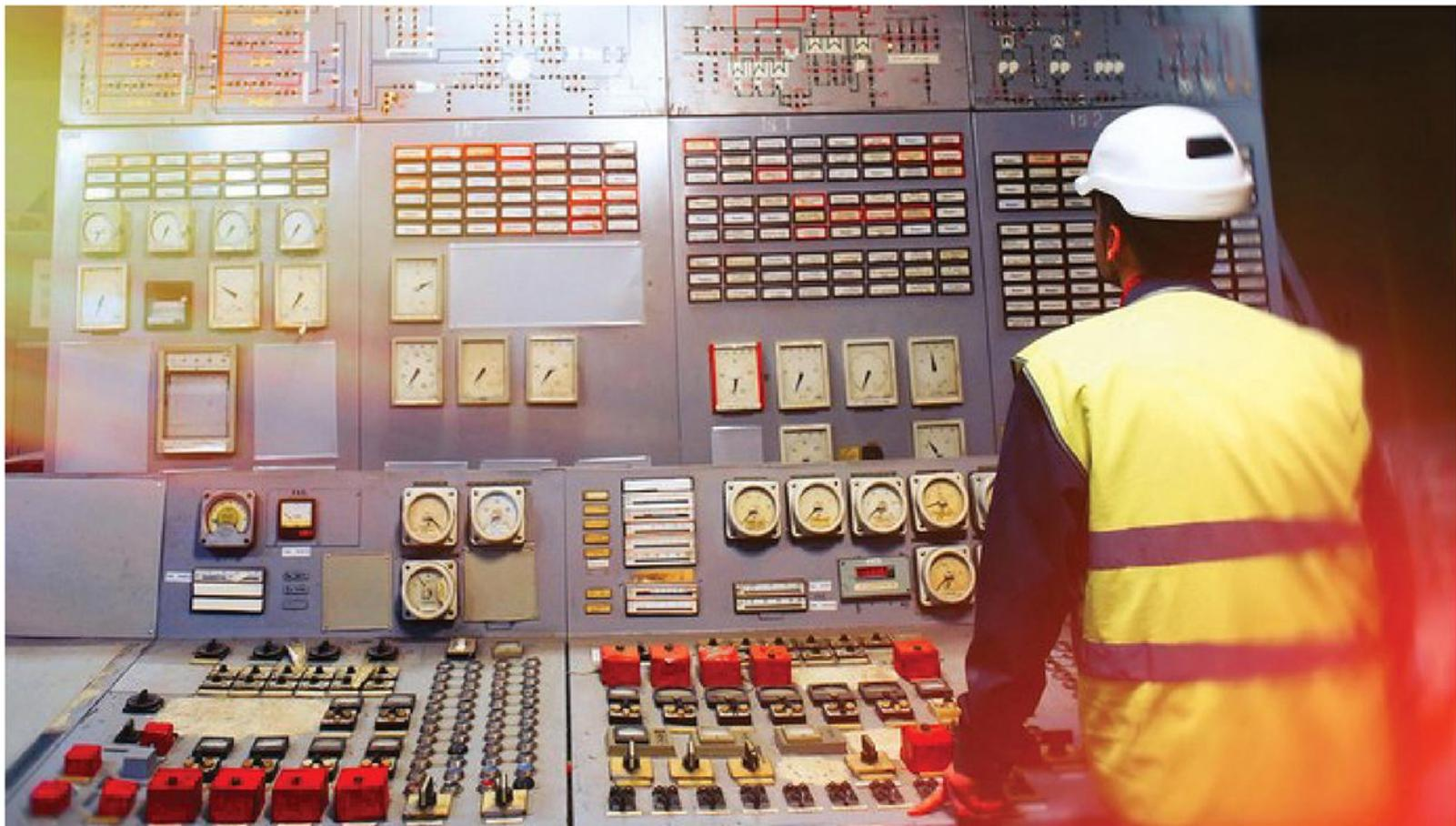
يعتمد برنامج المراقبة والتحكم عن بعد "SCADA System" على تجميع البيانات من أجهزة التحكم المبرمجة وموزعات الشحن الخاصة بمحطات الغاز الطبيعي المضغوط؛ وكذلك بيانات السيارات التي تم شحنها بالغاز الطبيعي المضغوط وبيانات حاويات الغاز الطبيعي المضغوط (الضغط - عدد مرات المليء والتفريغ) وببيانات القدرة الكهربائية المستهلكة لمحطات الغاز الطبيعي المضغوط حتى يتضمن للشركة متابعة جميع ظروف التشغيل والمعدات بالشركة.
